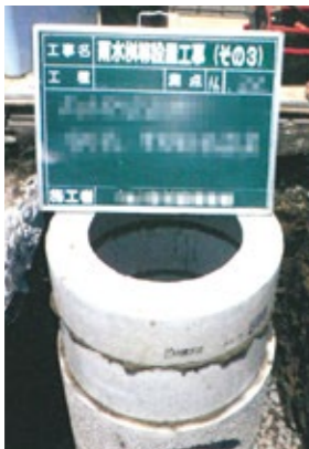
▲浸水対策として設置された雨水枡
