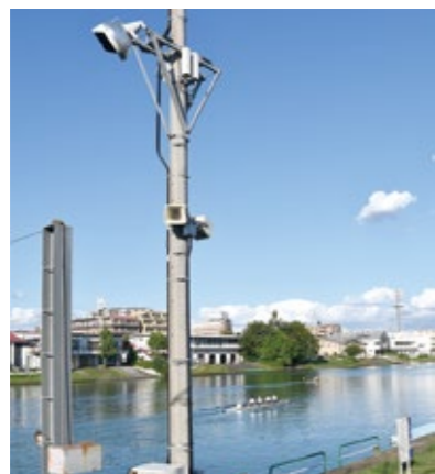
▲漕艇場に沿って設置されているスピーカー
