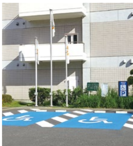
◀屋根のない障がい者用駐車場
