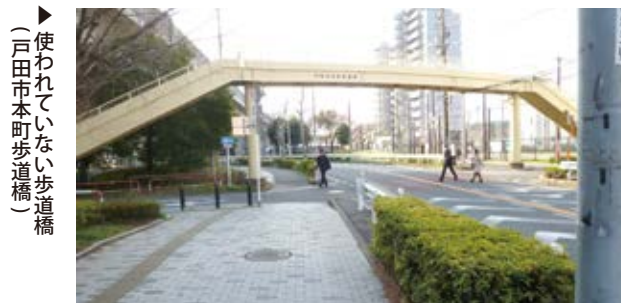
使われていない歩道橋（戸田市本町歩道橋）
