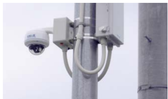
▲防犯カメラ21台を、市内3駅周辺を中心に設置しています。
