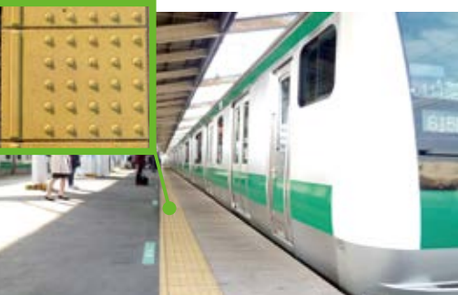
戸田公園駅にある内方線付き点字ブロック。平成29年度は戸田駅、北戸田駅に設置予定。
