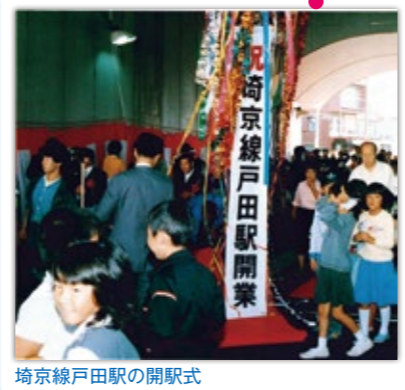
埼京線戸田駅の開駅式
