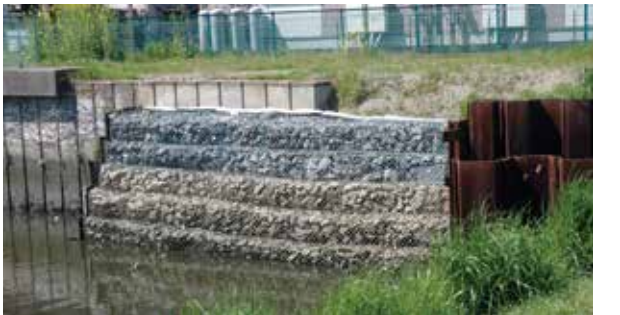
修繕工事の終わった緑川
