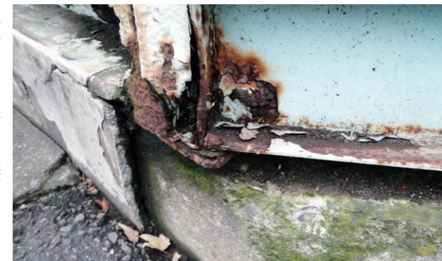
腐食している喜沢中学校の防音壁土台部分
