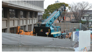
▲耐震等改修工事の公共施設（市役所本庁舎）
