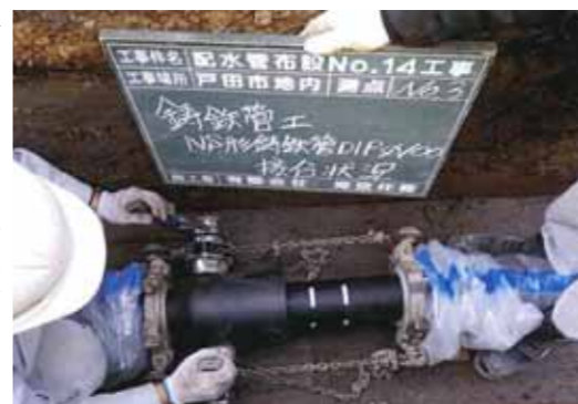
水道の耐震管布設状況
