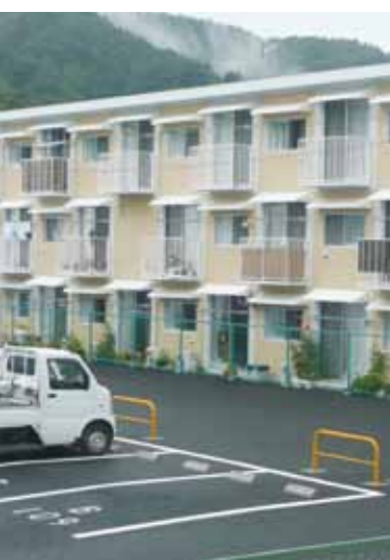
▲コンテナを使った3階建ての仮設住宅 (宮城県女川町)
