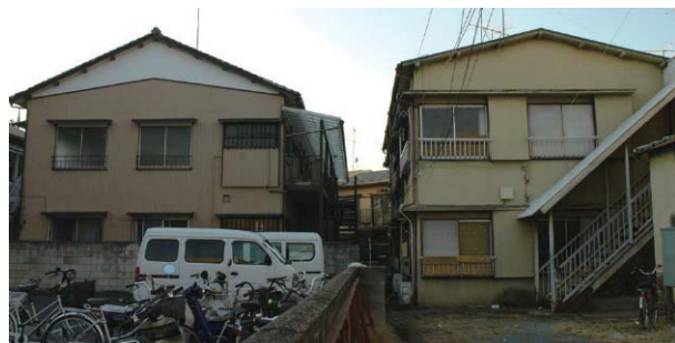
▲市内にまだ多く残る賃貸住宅
