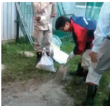
▲放射能除染作業（戸田第一小学校）
