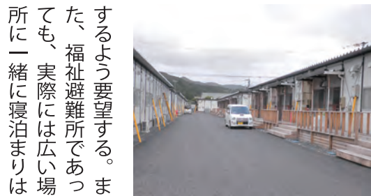
▲女川町総合運動場の仮設住宅
