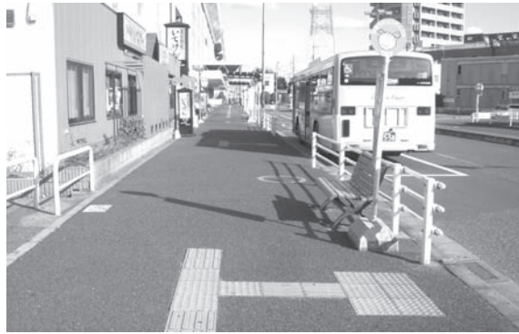
▲駅から途切れた点字ブロック
