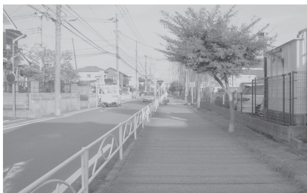
▲新曽中央地区のシンボルロードとして整備される予定の地下水路
