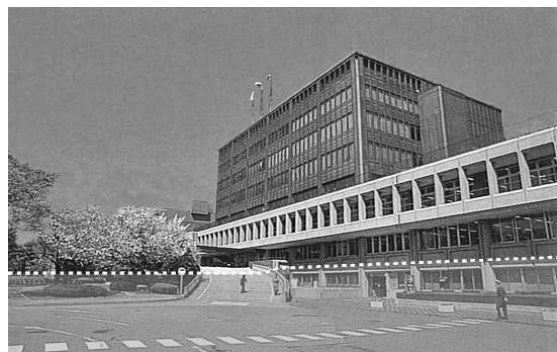
▲荒川が破堤すると、この位置まで水没します
