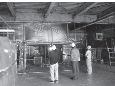
▲民間建築物アスベスト除去工事にかかる養生確認のための立ち入り検査
