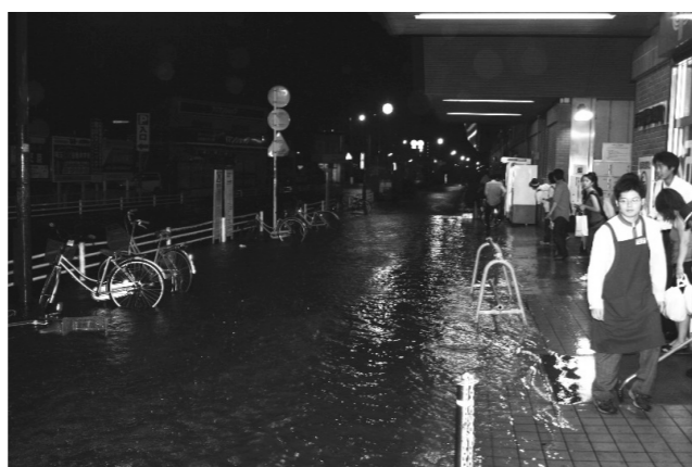
▲平成17年9月の集中豪雨で水没した戸田駅前の道路
