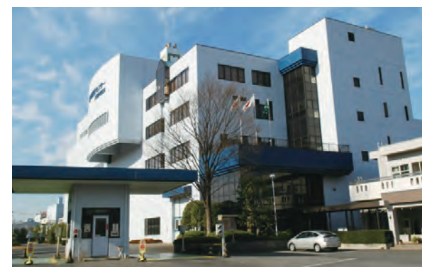
火災により追加でかかった経費の半分の交付される見込み
