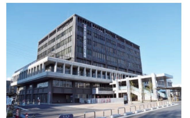
建築から55年が経過した市庁舎
