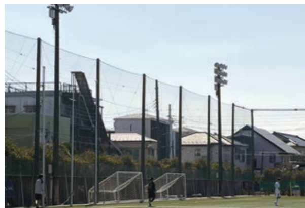
惣右衛門公園サッカー場の照明設備
