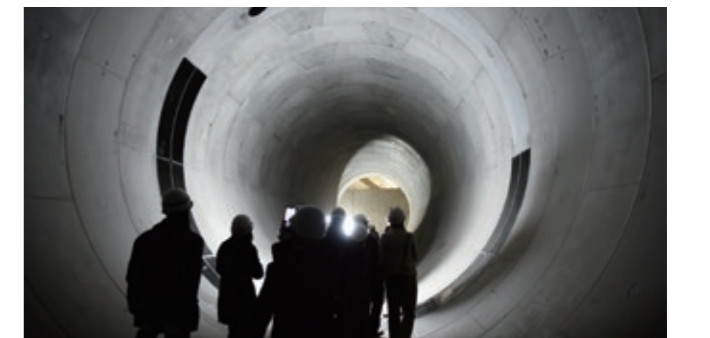
浸水被害の軽減が期待される雨水貯留管
