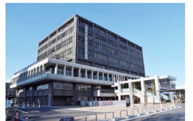
建築から55年が経過した市庁舎
