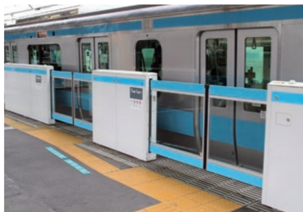
JR東日本のホームドア：従来型ホームドア（標準タイプの基本）
