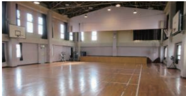
工事が予定される東部福祉センター体育室
