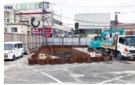
西鉄柳川駅前に水路を引き込む工事
