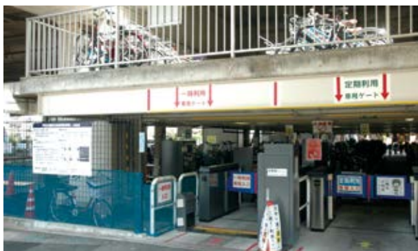
▲自動ゲートが設置された戸田公園北自転車駐車場
