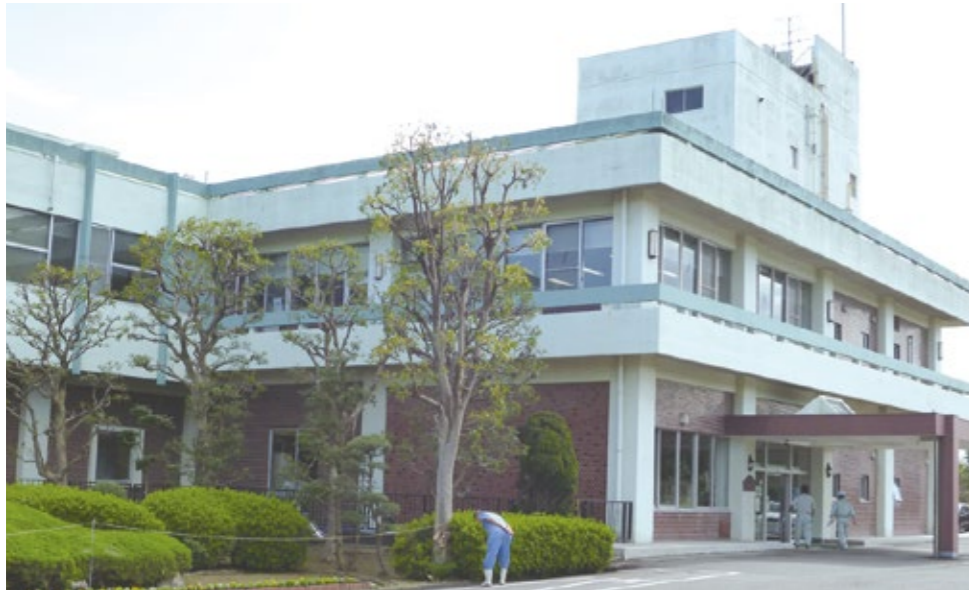
▲荒川水循環センター(下水道終末処理場)
