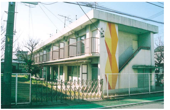
▲解体予定の教職員住宅
