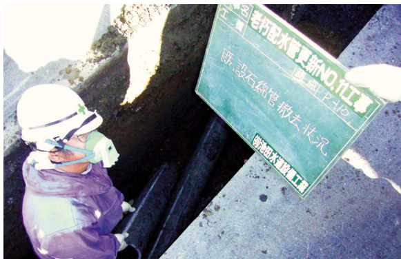
▲ 昨年度実施されたアスベスト水道管撤去作業
